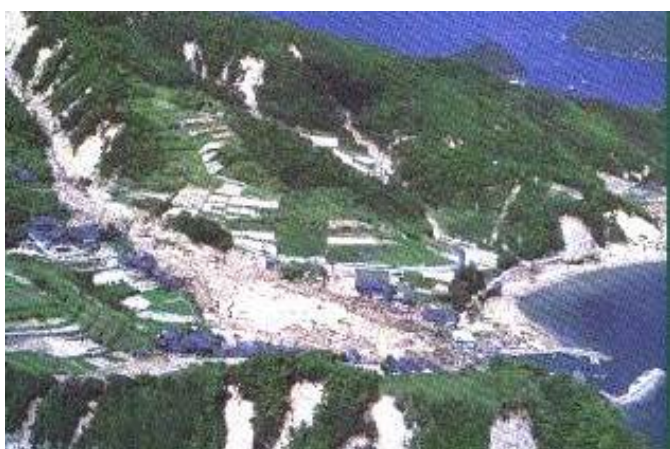
写真 3 谷尻地区の土石流による被災写真
