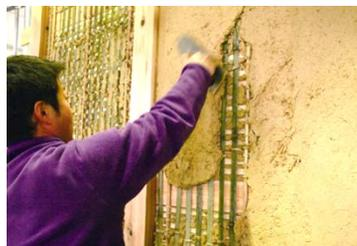
日本の歴史的建造物の壁には、伝統技術である土塗壁が使われています。見学ツアーでは土塗壁の材料や作り方とともに、その強さを簡単な実験を通して紹介します。
