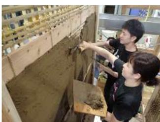
日本の歴史的建造物の壁には、伝統技術である土塗壁が使われています。見学ツアーでは土塗壁の材料や作り方とともに、その強さを簡単な実験を通して紹介します。
