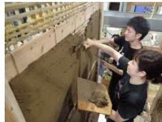
日本の歴史的建造物の壁には、伝統技術である土塗壁が使われています。見学ツアーでは土塗壁の材料や作り方とともに、その強さを簡単な実験を通して紹介します。
