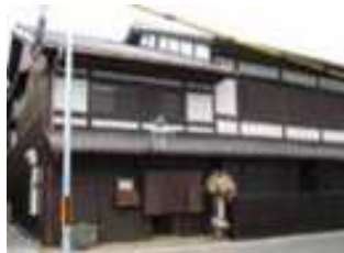
民家を転用した高齢者の小規模多機能ホーム
