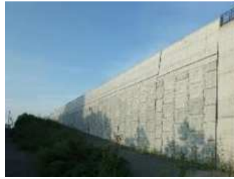
土でつくられた社会基盤構造物の例（補強土壁）
