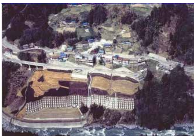
写真2 今久保地区の地すべり対策の全景 (2007年撮影)
