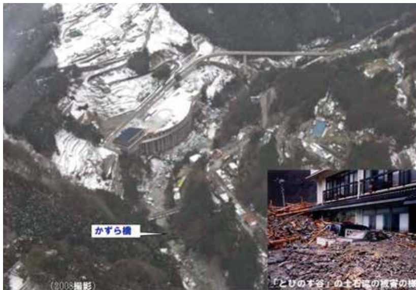
写真1 祖谷のかずら橋周辺の善徳地すべり地帯と「とびのす谷」の土石流写真 (2007年2月撮影)
