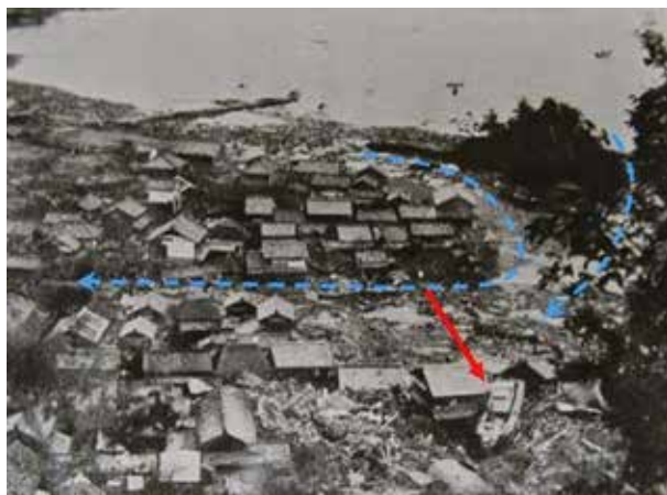
写真2 津波に襲われた直後の浅川の被害 (海陽町提供写真に一部加筆)
