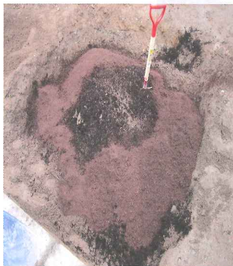
c) 土壌改良材混ぜ合わせ
