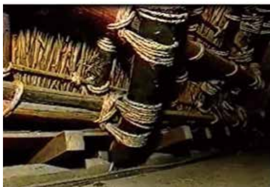
写真 3 水陸両用と例えられたよしぶき屋根裏の様子
