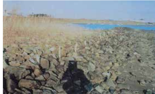
水制頭部(縦工)の状況 (H8. 2. 22 撮影)
