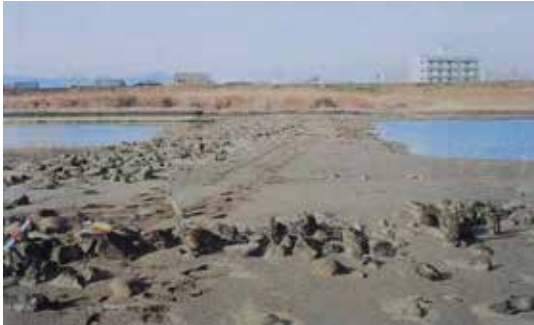
写真2 水制幹部(横工)の状況 (H8. 2. 22 撮影)
