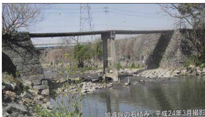
写真1 下流への洪水を加減する「加減閘(堰)」
