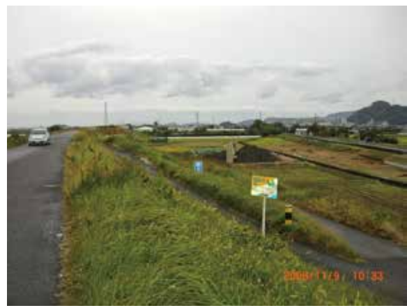
写真2 ガマン堰があった付近の那賀川堤防
