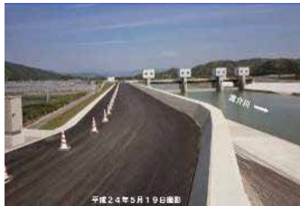
写真3 波介川河口導流堤防や水門
