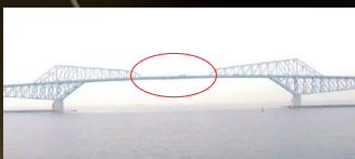
東京ゲートブリッジの光ファイバー-FBGは伊興電線株式会社によって製造され、NTTインフラネット株式会社によって、写真のCの部分に施工されました。
