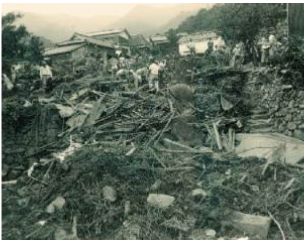
写真1 谷尻地区の被災状況 (香川県提供写真)
