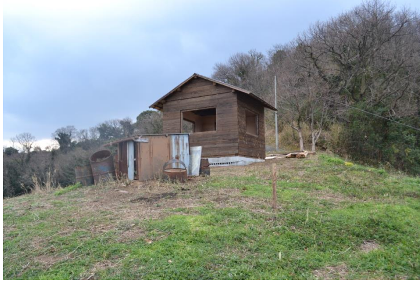
図7 建設途中の見晴らし小屋
