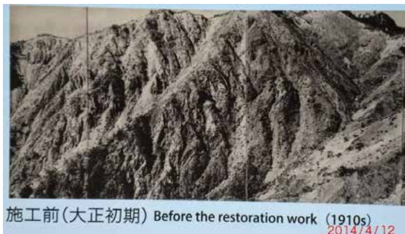
写真3 施工前(大正初期)の加奈木崩れの現地看板写真
