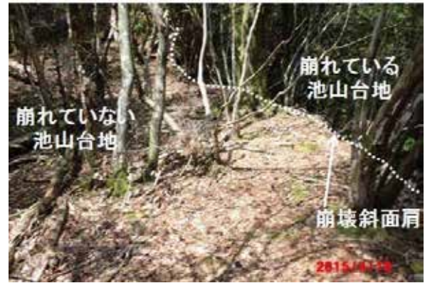
写真5 池山台地崩壊斜面肩の様子 (H27年4月撮影)
