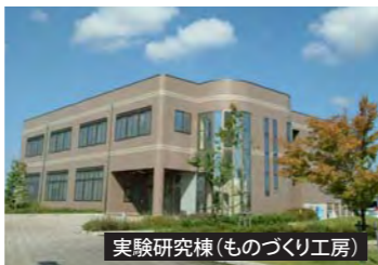
実験研究棟(ものづくり工房)
