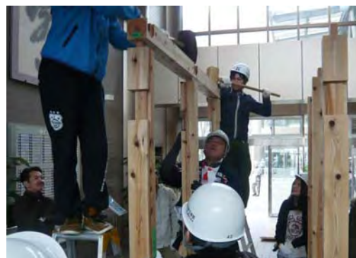
「ZENKON 湯」の組み立て作業
