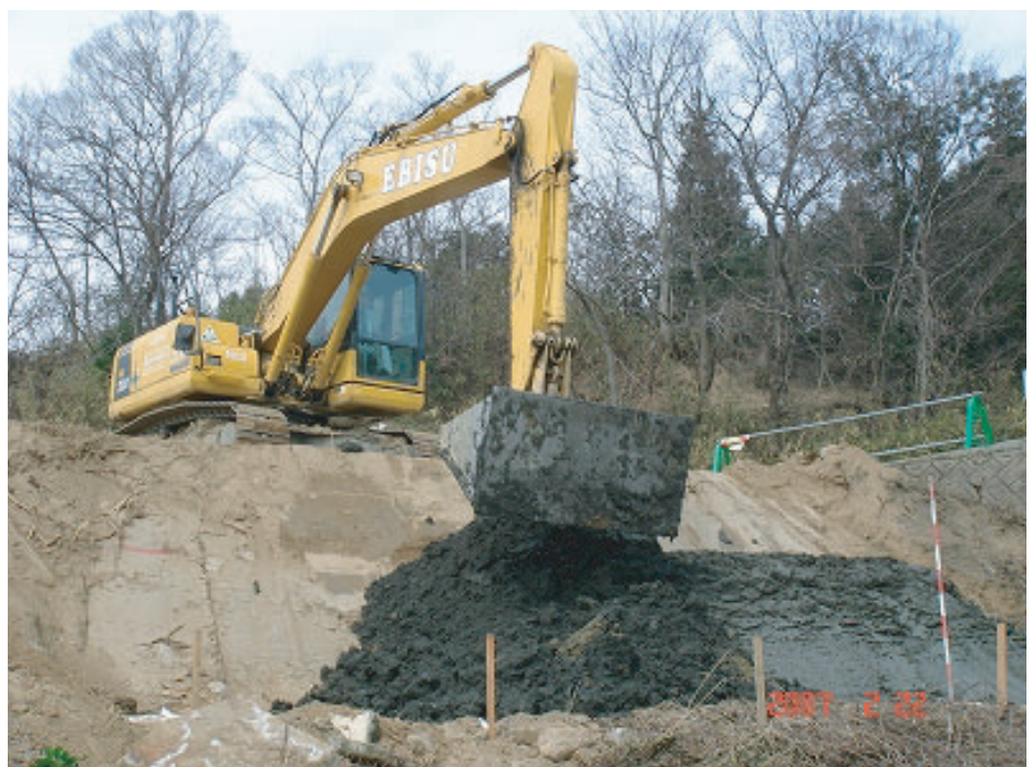
H75 試料の配合直後における貼り付け実験 貼り付け作業（配合 3.5 時間後、H75）
