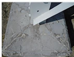
ASR 損傷を受けた鉄塔基礎
