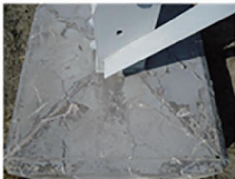
ASR 損傷を受けた鉄塔基礎
